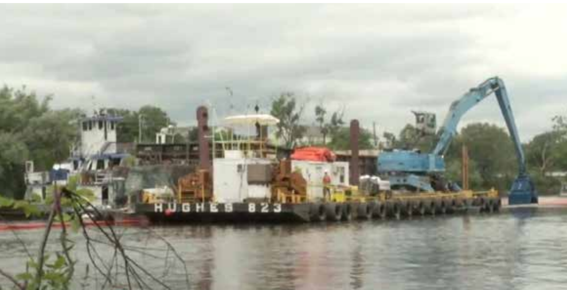
Limpieza mediante maquinaria del Passaic, Nueva Jersey
