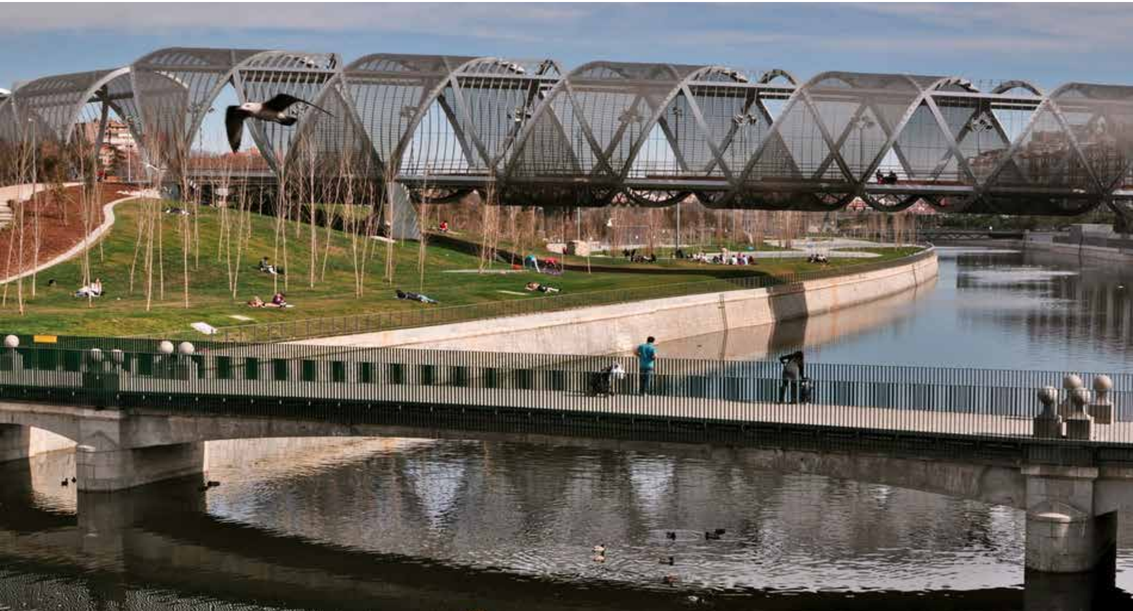
Puentes peatonales en el río Manzanares, Madrid Río
