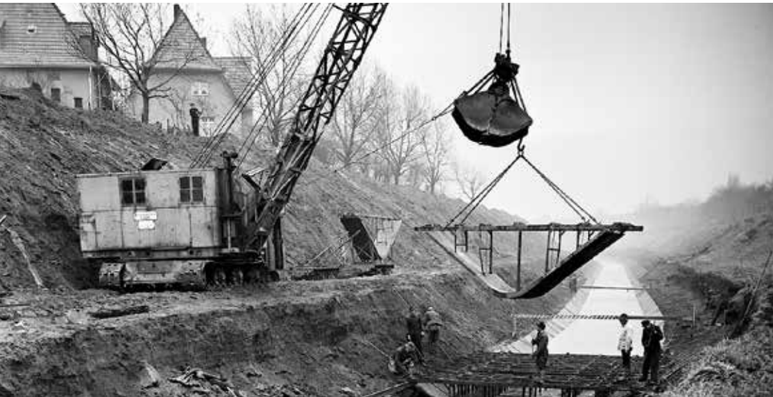
Río Emscher antes de la renaturalización
