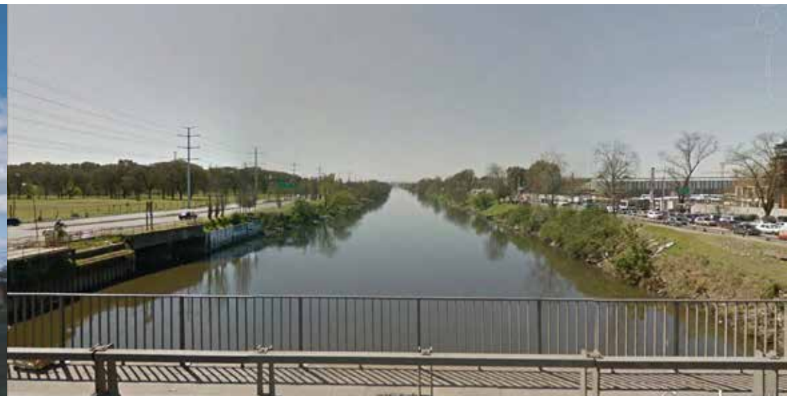
Puente de la Noria 14
