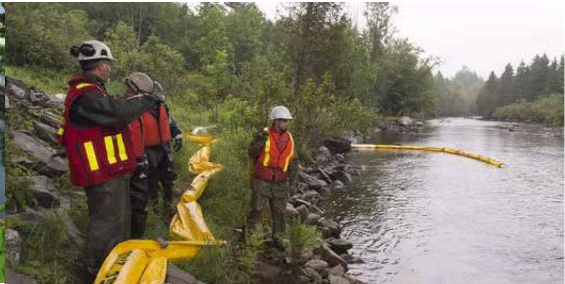
Decontaminación del Chaudiere, Canada
