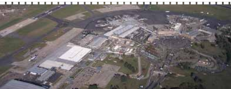
Tramo alto Aeropuerto Internacional - Bosques de Ezeiza
