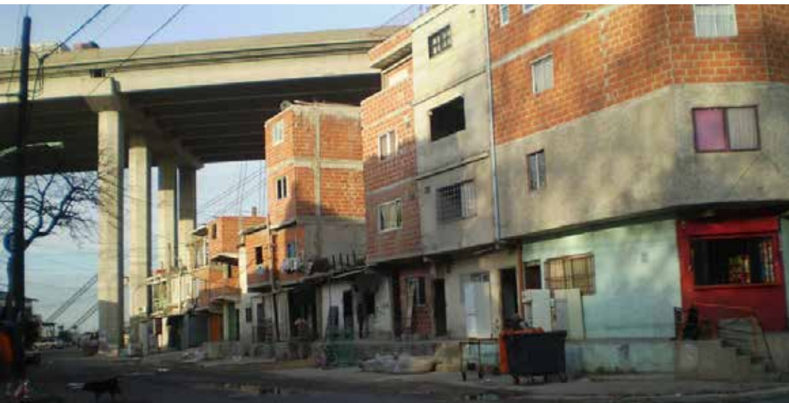
Vivienda precaria bajo la autopista Buenos Aires-La Plata
