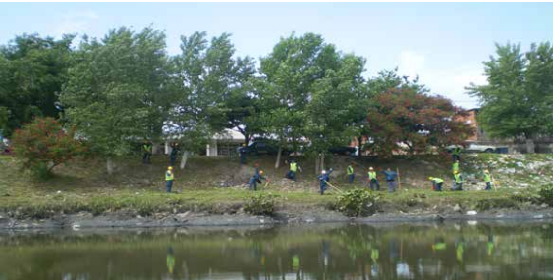
Limpieza del río - cooperativas de trabajo AySA
